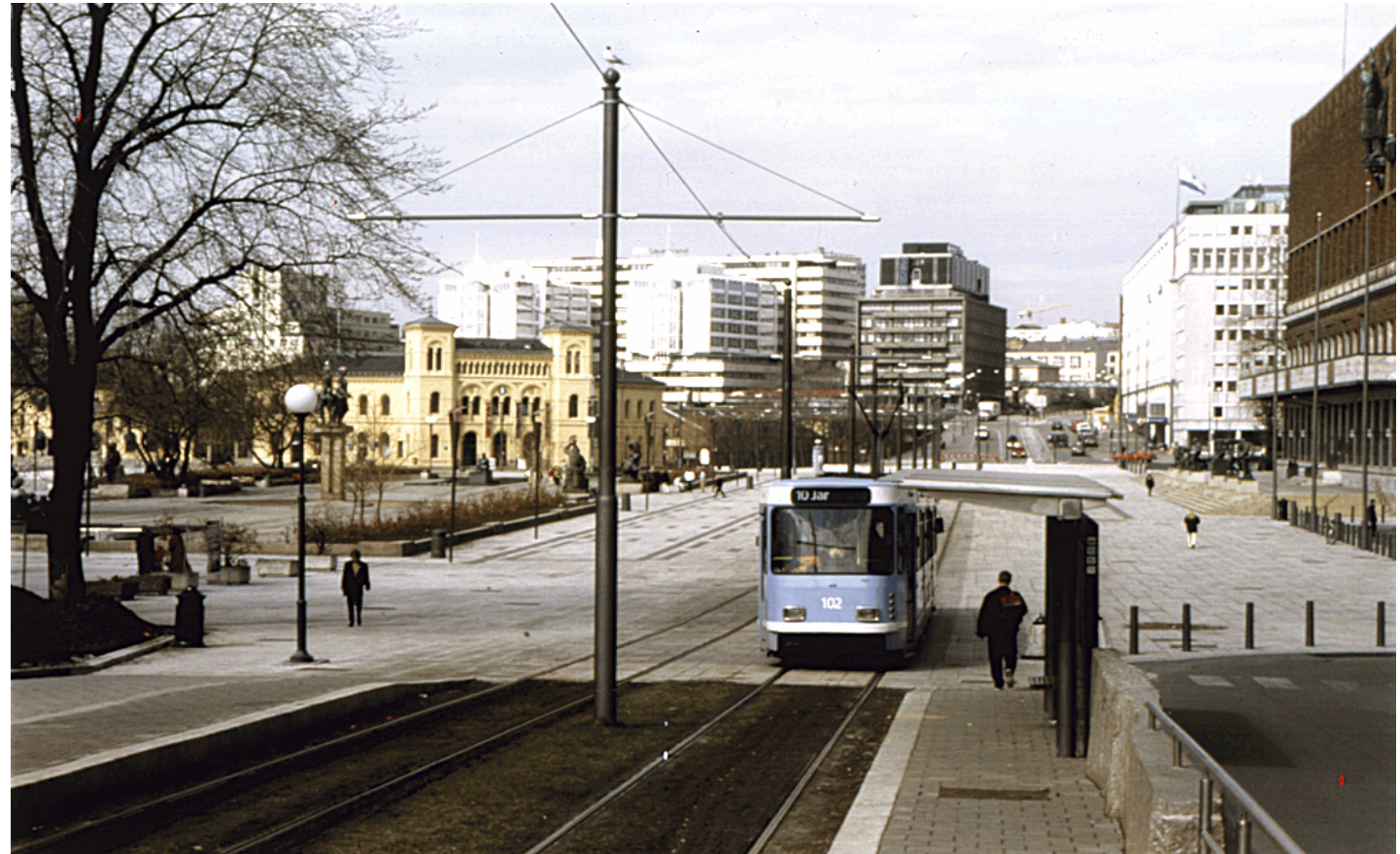
Photo: Mari Kollandsrud, Riksantikvaren
